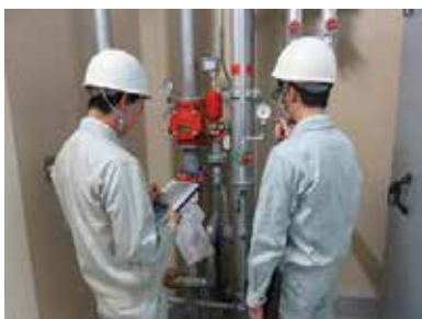
現地調査の様子
